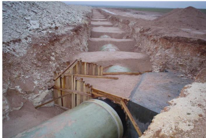
Not: Büyuk çaplı CTP borularının saha basınç testi yapılrken (genelde 10 bar üzeri) CTP manşonlarının dönme yapabileceği riski göz önünde bulundurulmalı, yüksek basınçlı hatlarda manşon üstleri açıkken ve gömlekleme işlemi tamamlanmamışken basınçlar arttırılmalıdır. Test esnasında manşonlarda dönme tespit edilirse test hemen durdurulmalı, yerinden oynayan manşonlar tekrar merkezlendikten sonra test tekrarlanmalıdır.
