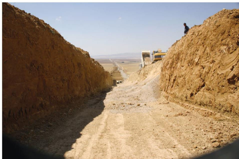
Iyileştirme işlemi sonrası hendek tabanı hazırlanması
